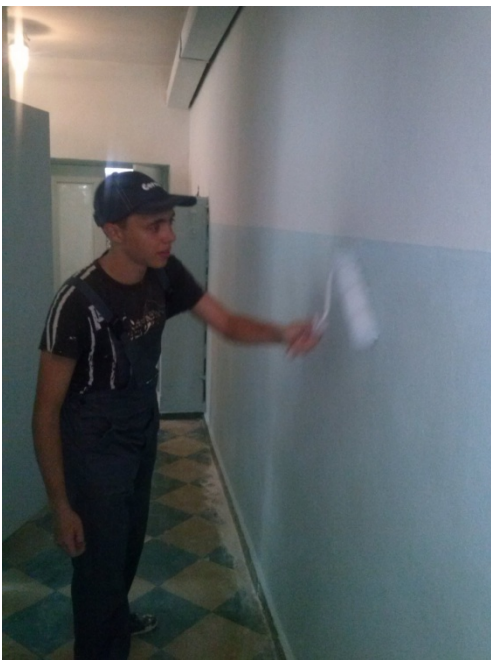
Забарвлення поверхонь стін акриловою фарбою кистями, валиками. Виконує учень групи №7, професія «Штукатур, маляр»
